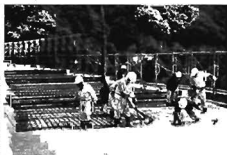
Hình 8c. Lắp đặt cốt thép và đổ bê tông
