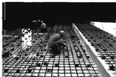
Hình 8c. Lắp đặt cốt thép và đổ bê tông
